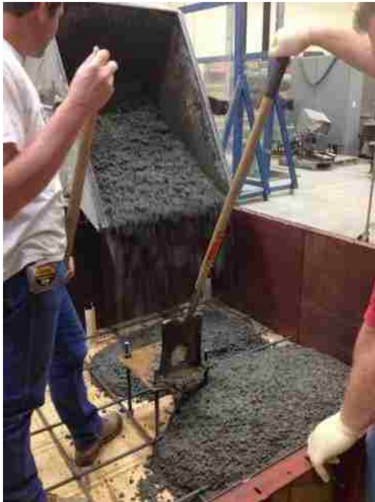
Figure 3-10: Footing Concrete Pour
